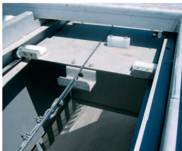
Sistema de separación de grasas semiautomático mediante rasqueta.
