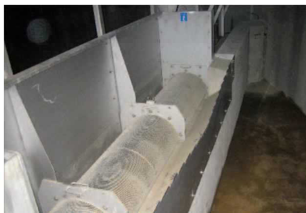
ROTAMAT® RoK 2 内置一测量堰板，用于测量暴雨排放量
