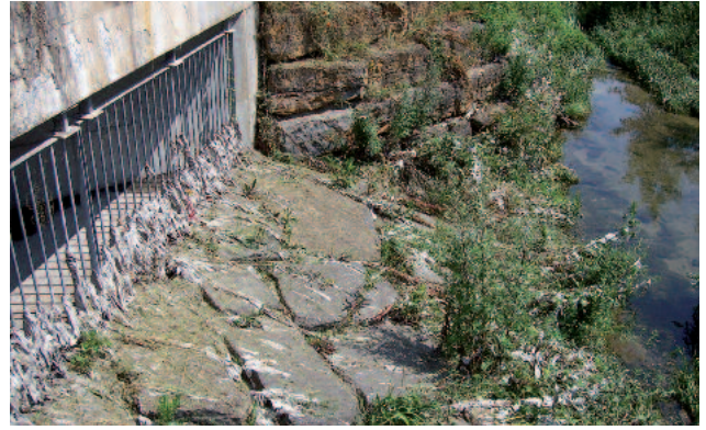
暴雨过后，典型的不配置过滤器的雨水排放构筑物外观
