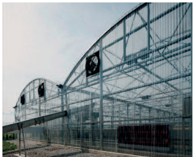
Alimentação de lodo automatizado com sem-fim
