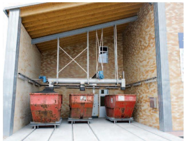
Armazenagem de lodo seco necessário para a seleção da forma de disposição
