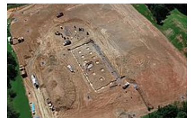
Trabajos de construcción
