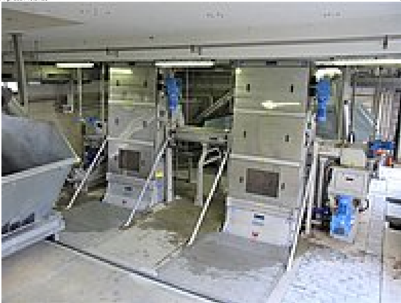
La reja de gruesos HUBER RakeMax® HF, con su estructura de bastidor acodado, apenas se distingue desde fuera de la máquina básica RakeMax® probada.
